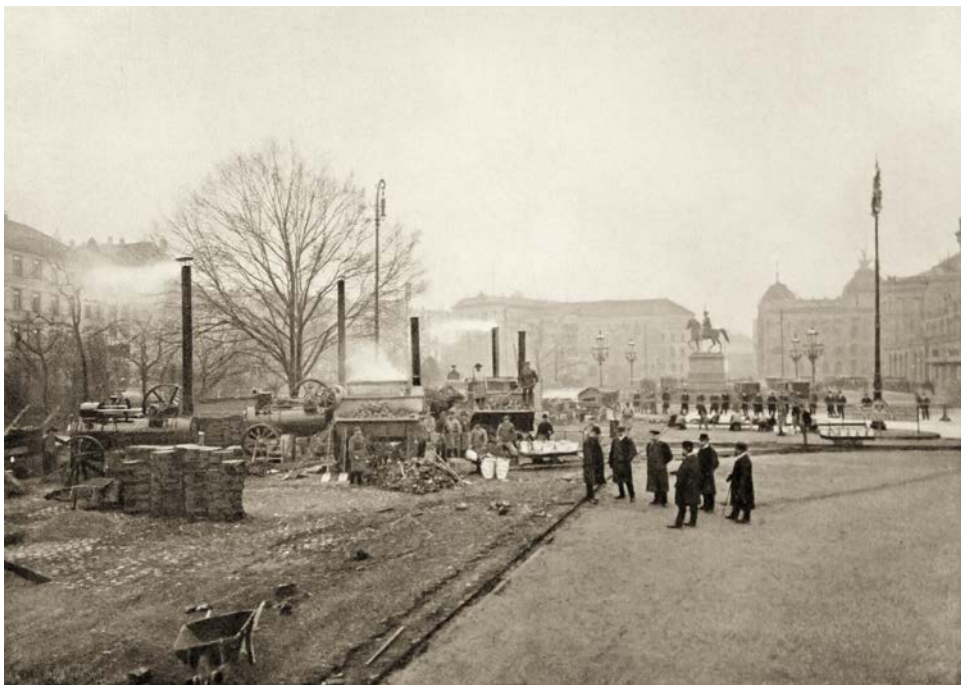
Abb. 25 Herstellung der Hartgussasphaltdecke auf dem Ernst-August-Platz vor dem Gebäude
