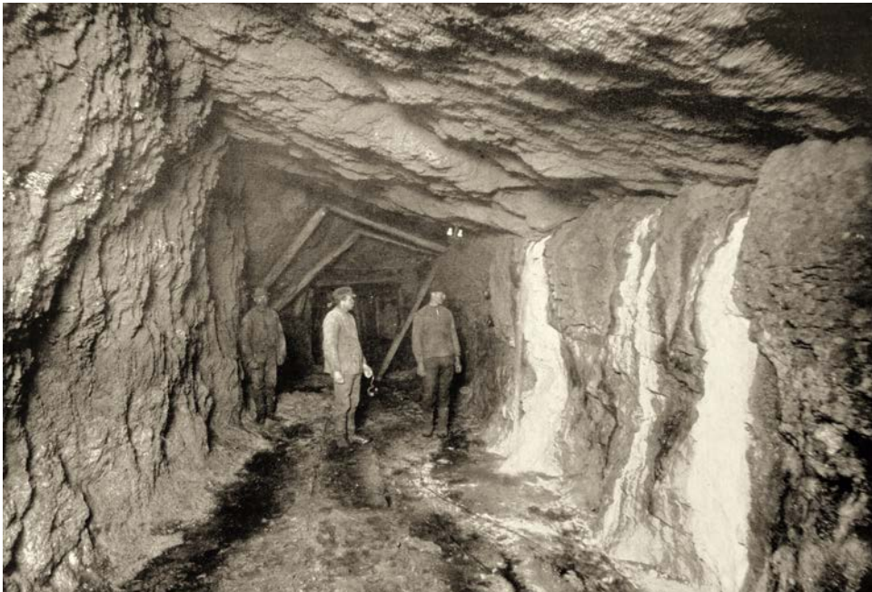
Abb. 16 Unterirdischer Abbau des Asphaltsteinlagers mit Austritt schwefelwasserstoffhaltiger Quellen „in dem Limmer Bergwerk“ (gemeint ist das DASAG-Bergwerk in Ahlem). Aus DASAG (1926).
