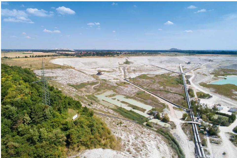
Abb. 1 Die etwa 50 m tiefe Mergelgrube mit den Förderbändern, die Mergel von den drei aktiven Abbaustellen abtransportieren (Foto: Fa. Holcim)
