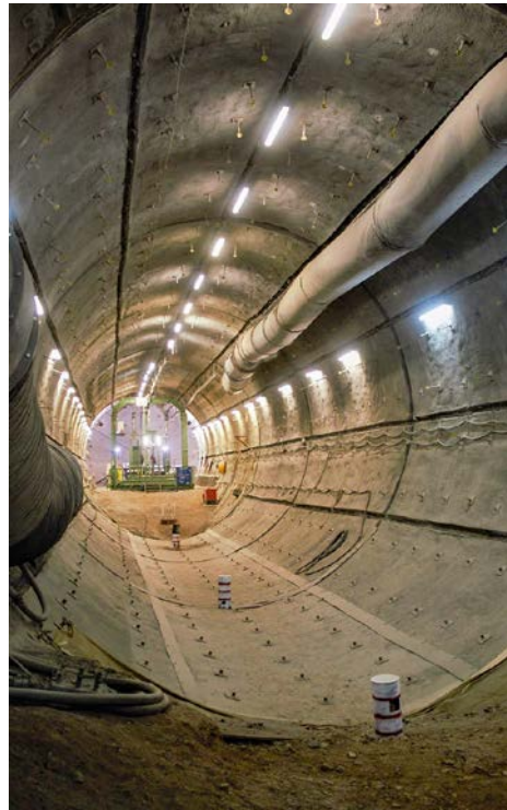
Abb. 5 Schachtstollen im Ausbau
