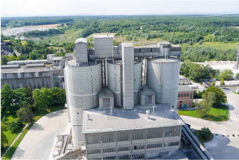
Abb. 6 Silos für fertigen Zement und darunter die Packerei, links dahinter der ältere Teil der
