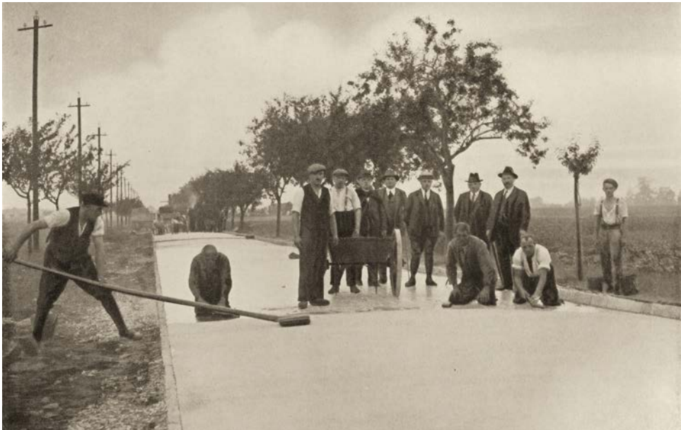
Abb. 27 Herstellung von Hartgussasphalt „auf alter Chausseierung mit Beton-Ausgleich“, Landstraße Hemmingen-Devese, Hannover (vermutlich heutige Weetzener Landstraße in Hemmingen). Aus DASAG (1926).
